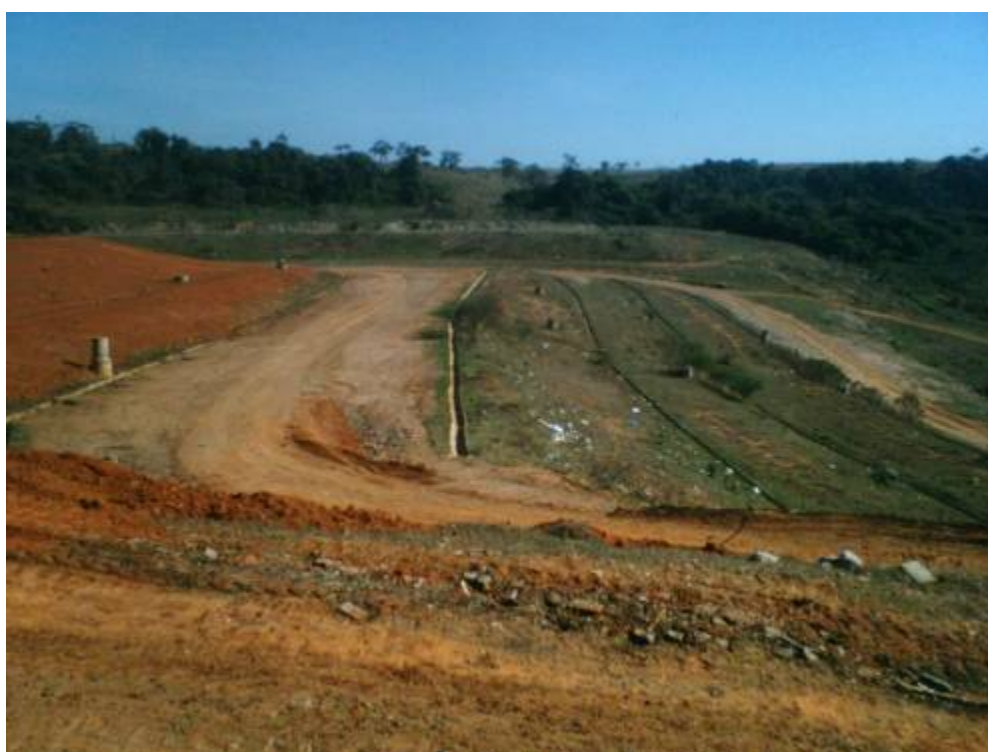
Figura 12 – Rede de canaletas em área para utilização futura
