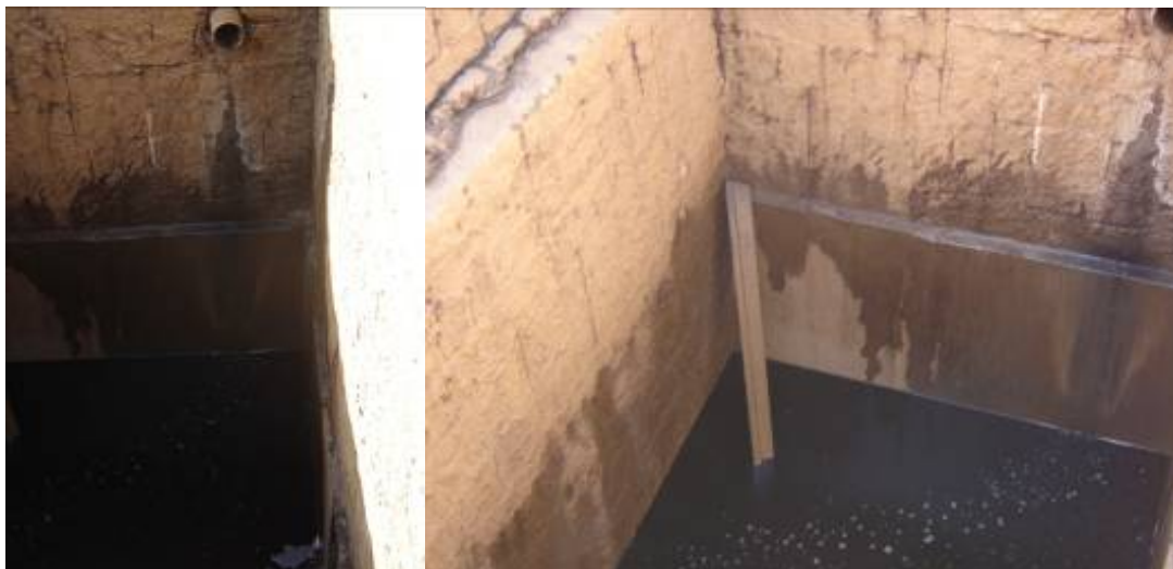
Figura 13 – Reservatório do chorume produzido
